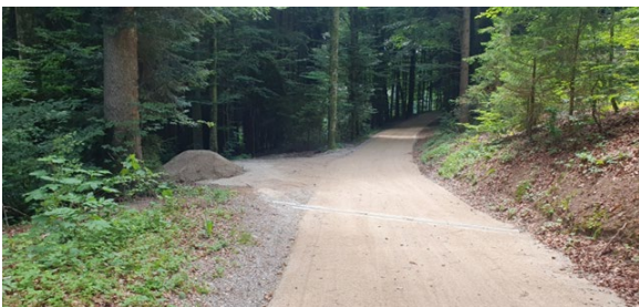
Naturstrasse nach Sanierung in Richtung Poffetsmüli
