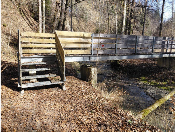
Verlängerte Brücke und neuer Widerlager
