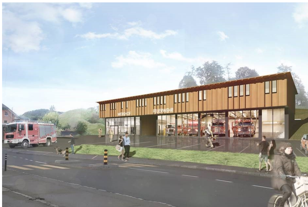
Frontansicht auf die Fassade des neuen Mehrzweckgebäudes
